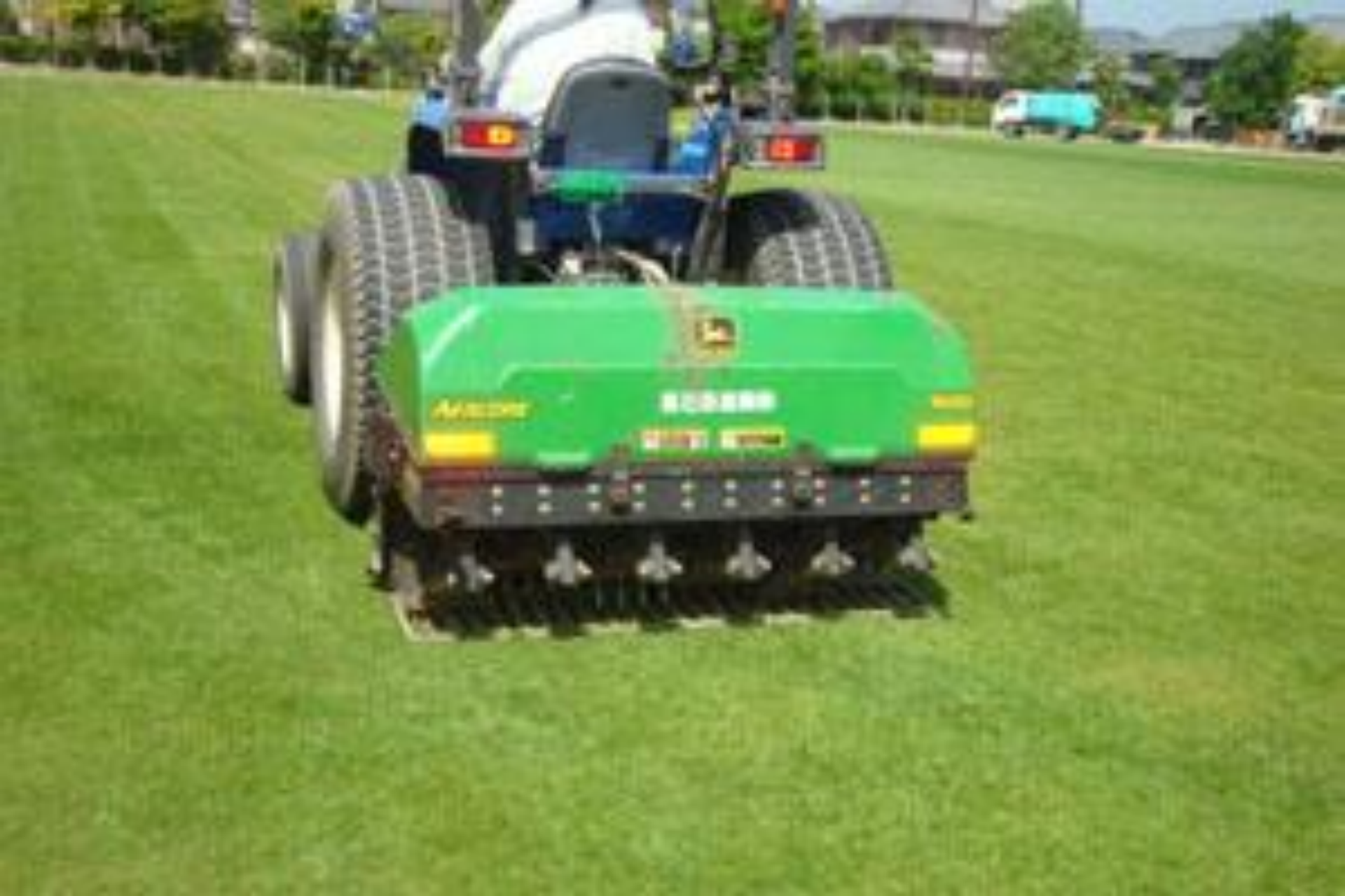
エアレーション工事
